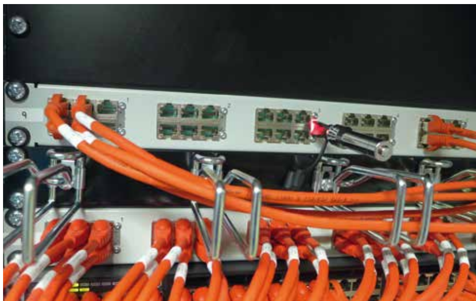
Bild 6. Dank der LED-Funktion ließen sich die zugehörigen Enden eines Trunk-Kabels schnell identifizieren und anschließen.
